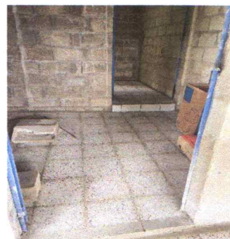
Foto 2: Remozamiento de pared
