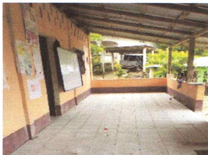
Foto 1: Sustrucion de piso ceramico por piso de granito
