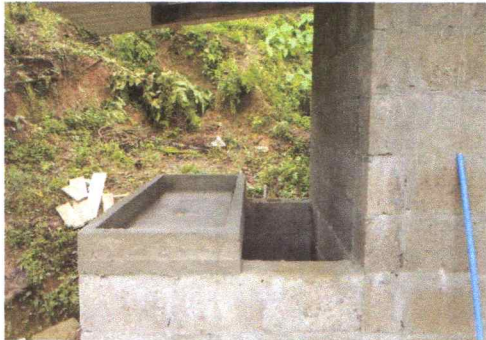
Foto 1: sustitucion de pila
