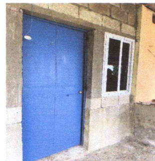
Foto 6: Sustrucion de puerta de madera por metal
