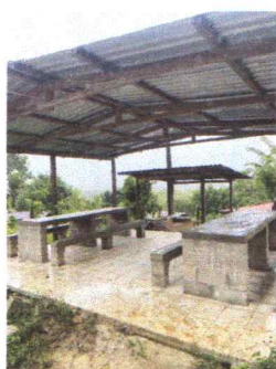
Foto 3: Sustrucion de Mezon y Banqueta
