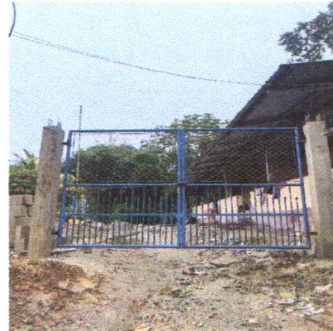
Foto 2: Sustitucion de porton
