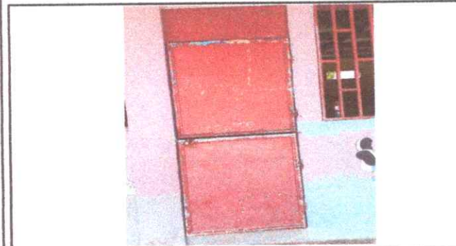
Foto 3: Limpieza y pintado
