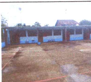
Foto 5: Mantenimiento de Techo
