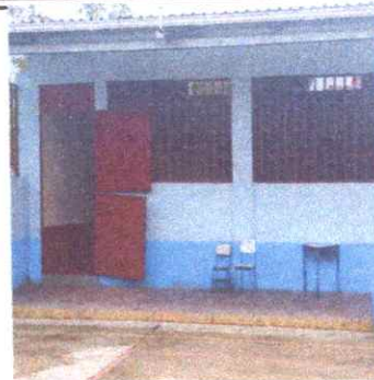
Foto 2: Sustitucion de Canales
