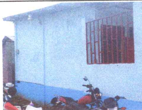
Foto 4: Limpieza y pintura
