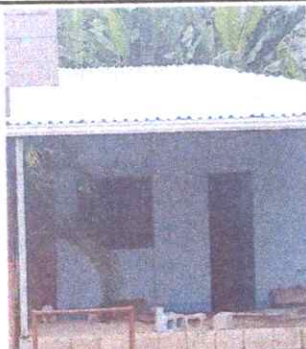
Foto 3: Sustitucion de techo y canales
