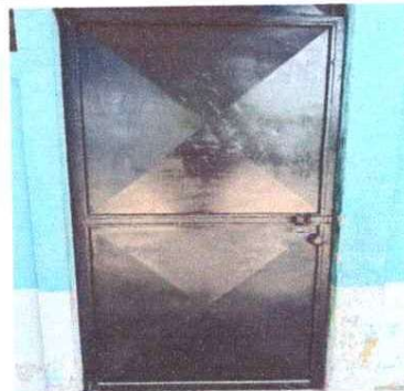
Foto 8: Sustitucion de chapa en Puerta de Metal
