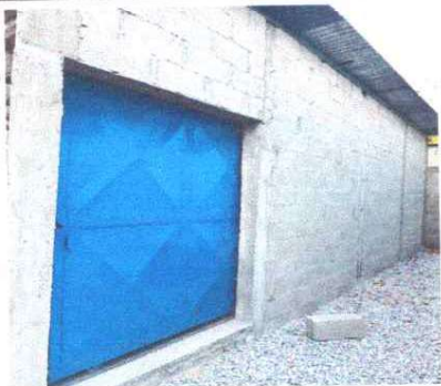
Foto 1: Cambio de lamina por block de paredes
