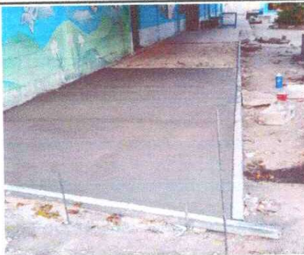
Foto 3: Piso Reparación
