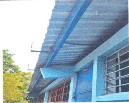
Foto 2: Canales y bajas de agua pluvial
