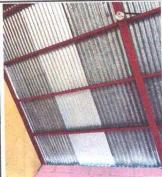
Foto7: Cubierta de lamina de 20 Pies
