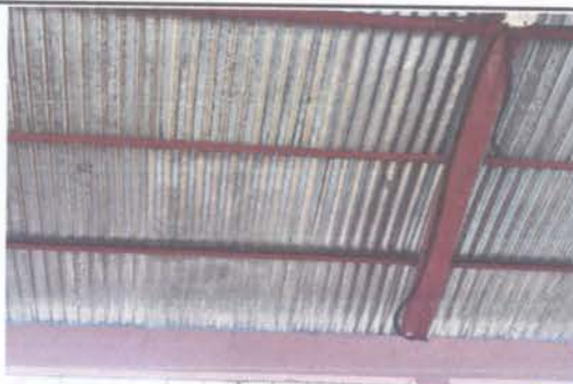
Cubierta de Lámina de 20 Pies
