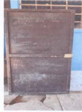
Sustitución de Chapa en Puerta de Metal
