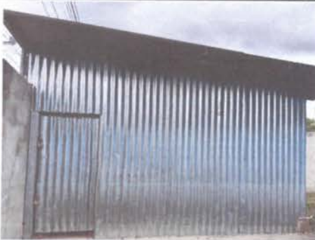
Cambio de Lámina por block de paredes
