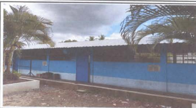
Canales y Bajas de Agua Pluvial
