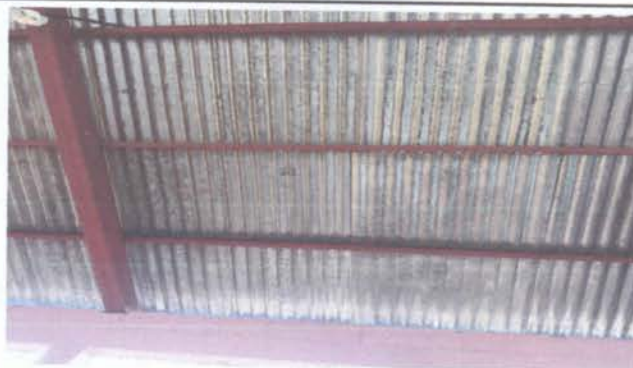
Cubierta de Lámina de 20 Pies
