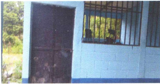
Foto 7: PINTURA DE MUROS EXTERIORES E INTERIORES
