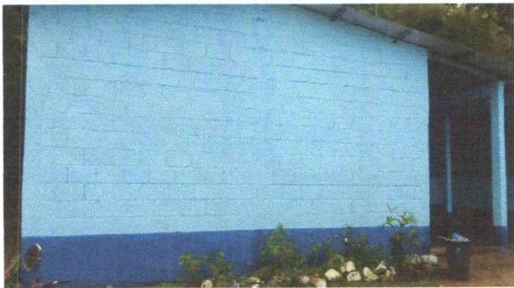
Foto 9: REPELLO DE MUROS
