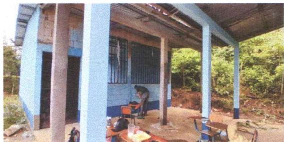
Foto 4: PINTURA DE MUROS EXTERIORES E INTERIORES
