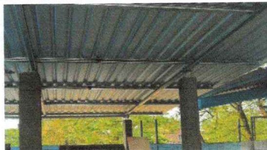
ESTRUCTURA DE LAMINA
