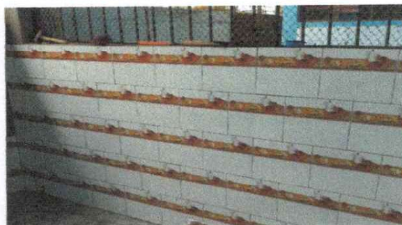
INSTALAR CERAMICO EN LA PARED
