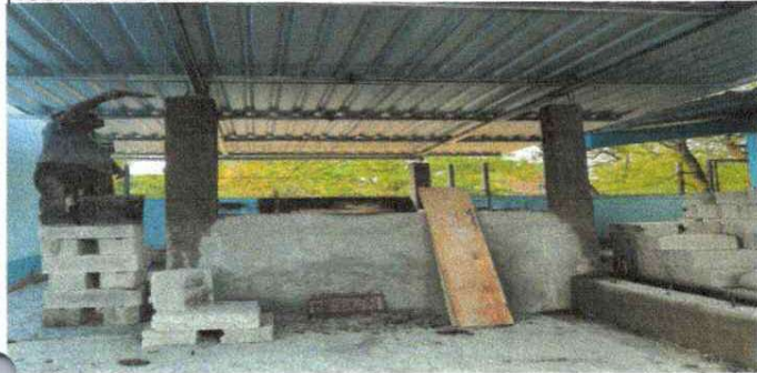
CUBIERTA DE LAMINA
