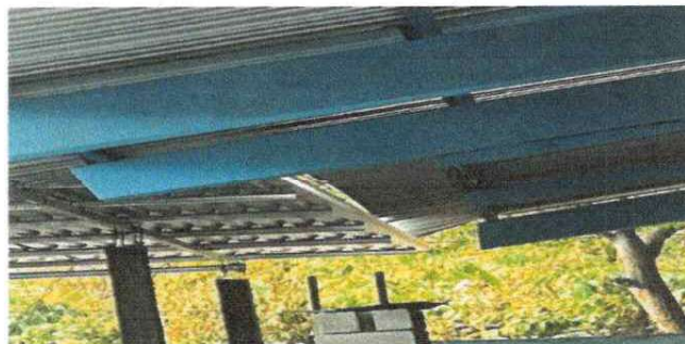
ESTRUCTURA DE LAMINA
