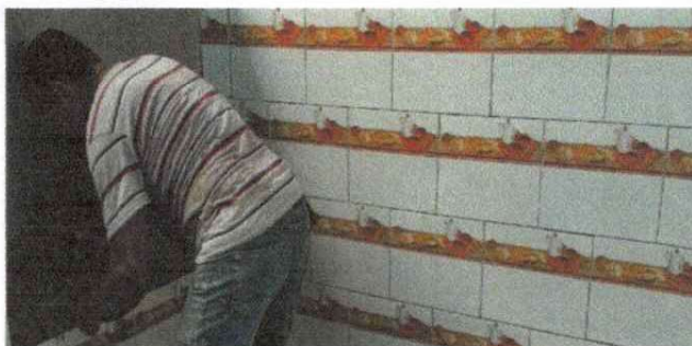
INSTALACIÓN CERAMICO EN LA PARED
