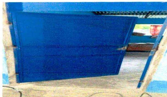
Foto 2: Sustitución de puertas
