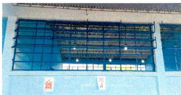
Foto 3: Mantenimiento de balcones de metal
