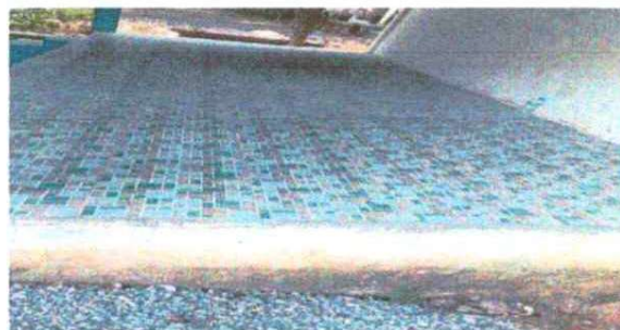
SUSTITUCION DE PISO CERAMICO
