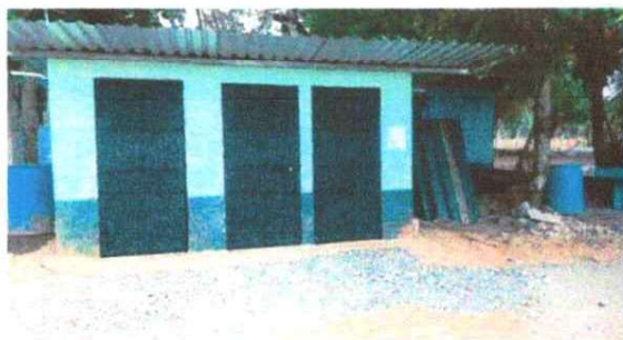
SUSTITUCION DE PUERTAS EN SERVICIO SANITARIO .
