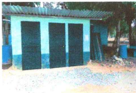
SUSTITUCION DE LAMINA, POR LAMINA TROQUELADA ALUZIC CALIBRE 26
