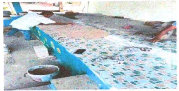
SUSTITUCION DE PISO CERAMICO
