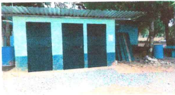
SUSTITUCION DE PUERTAS EN SERVICIO SANITARIO .
