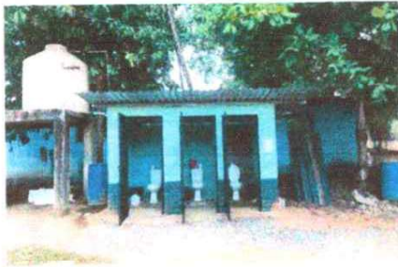
SUSTITUCION DE SEVICIOS SANITARIOS
