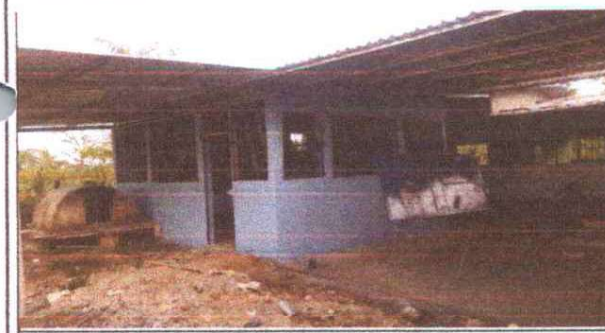
INSTALACION DE PUERTAS Y BALCONES DE COCINA
