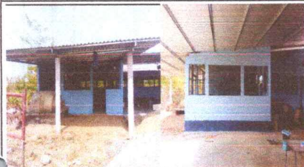
CONSTRUCCION DE LA COCINA FINALIZADA
