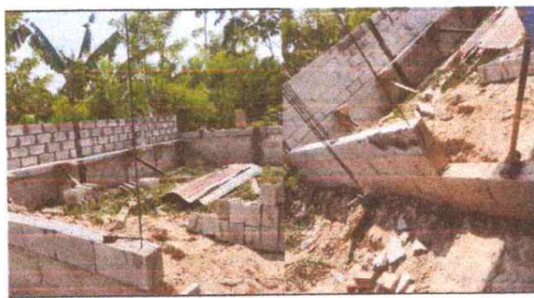
PROCESO DE LA CONSTRUCCION
