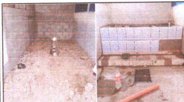
EN PROCESO PARA LA CONSTRUCCION DE LA PILA
