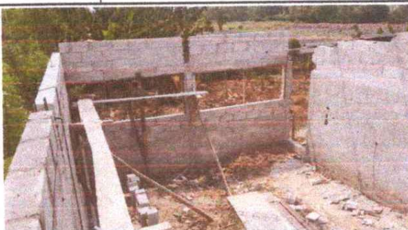
EN PROCESO PARA LA CONSTRUCCION DE LA COCINA
