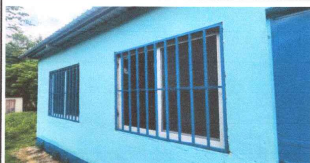
Foto 7: INSTALACIÓN DE BALCONES Y VENTANAS DE PVC.
