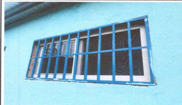
Foto 8: INSTALACIÓN DE BALCONES Y VENTANAS DE PVC.
