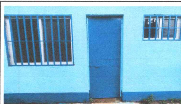
Foto 10: INSTALACIÓN DE PUERTAS METÁLICAS, INSTALACIÓN DE BALCONES Y VENTANAS DE PVC.
