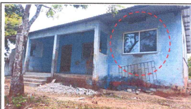
Foto 10: Suministro y colocación de Ventanas de PVC.
