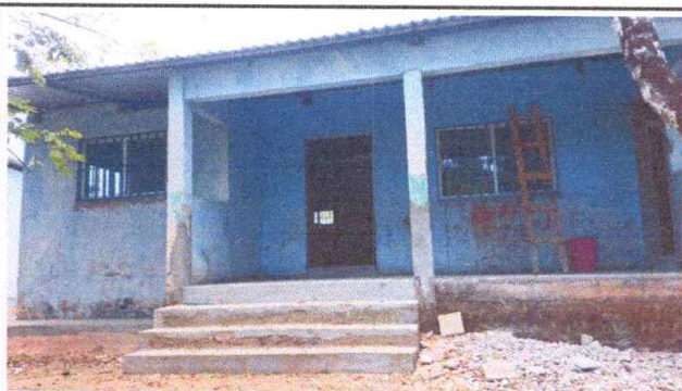
Foto 9: Reparación de gradas para el ingreso de las aulas.
