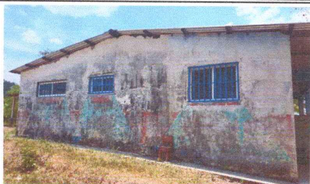
Foto 7: Suministro y colocación de Ventanas de PVC y balcones metálicos.
