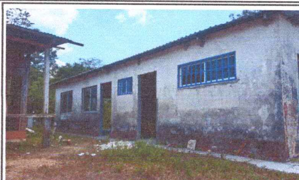
Foto 8: Suministro y colocación de Ventanas de PVC y balcones metálicos.
