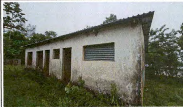
Foto 2: SUMINISTRO E INSTALACION DE VENTANAS DE PVC
