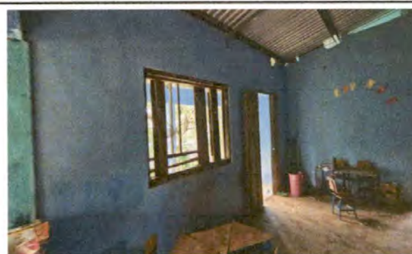
Foto 10 SUMINISTRO E INSTALACION DE VENTANAS DE PVC
