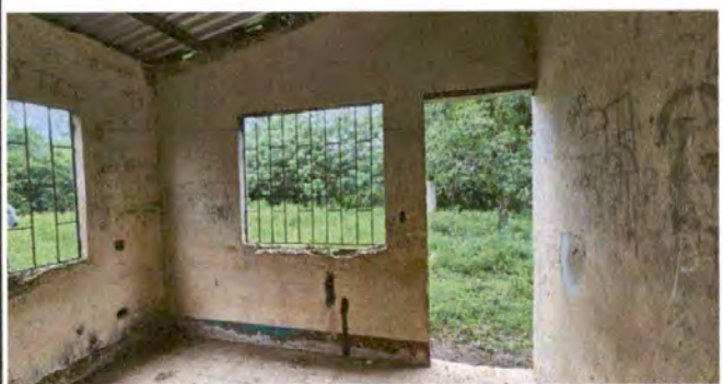
Foto 11: SUMINISTRO E INSTALACION DE VENTANAS DE PVC
