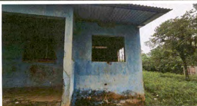
Foto 7: .SUMINISTRO Y APLICACION DE PINTURA EN MUROS
