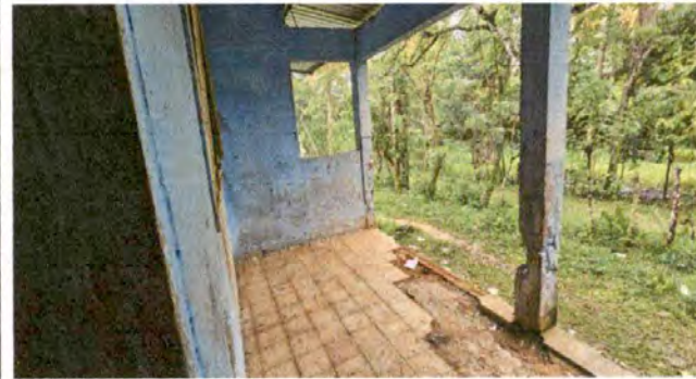
Foto 6: SUMINISTRO Y APLICACION DE PINTURA EN MUROS
