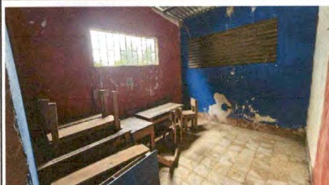
Foto 8: SUMINISTRO E INSTALACION DE VENTANAS DE PVC
