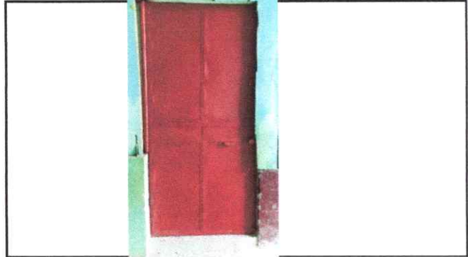
Foto 2: puertas nuevas de metal
