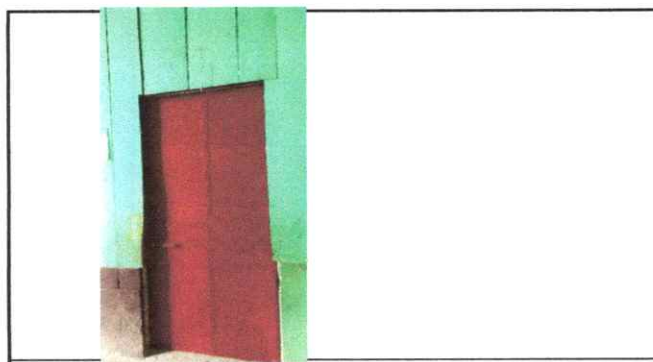
Foto 5: puertas nuevas de metal
