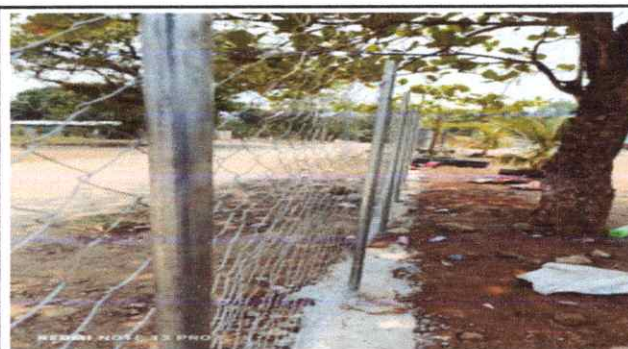
Foto 6: Colocacion de malla con tubos.
