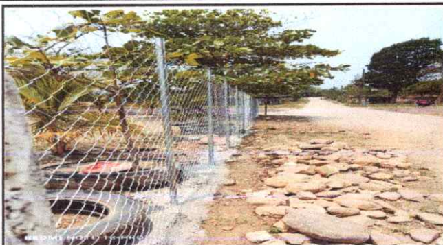
Foto 1: Colocacion de malla con tubos.
