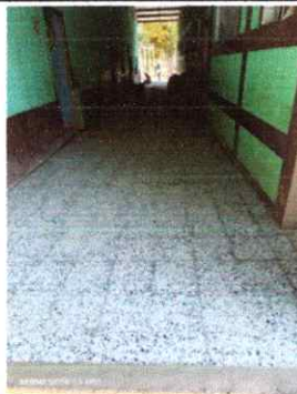
Foto 4 Finalizacion de pasillo
