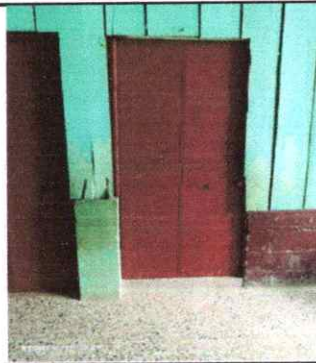
Foto 2: puertas nuevas de metal
