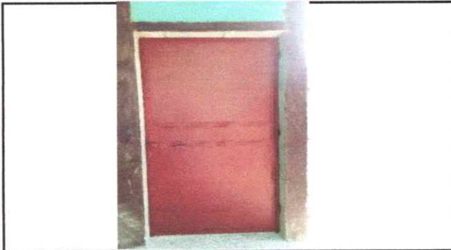
Foto 1: puertas nuevas de metal
