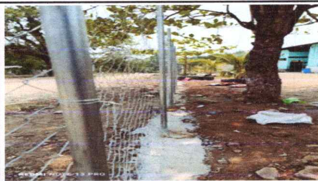
Foto 2: Colocacion de malla con tubos.
