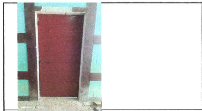
Foto 6: puertas nuevas de metal
