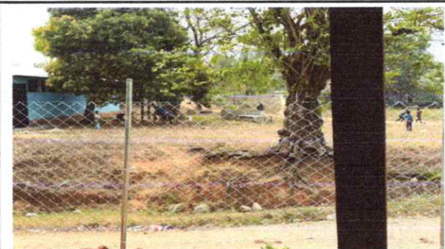
Foto 4: Colocacion de malla con tubos.
