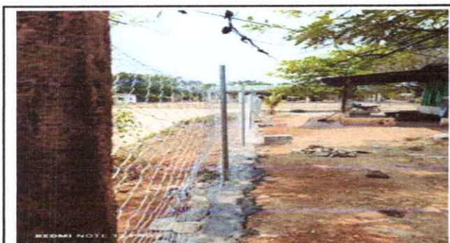
Foto 5: Colocacion de malla con tubos.
