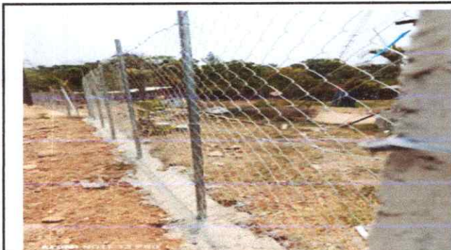
Foto 3: Colocacion de malla con tubos.
