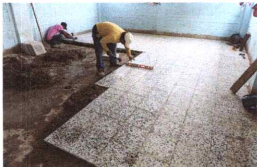
Foto1: Proceso de colocacion de piso
