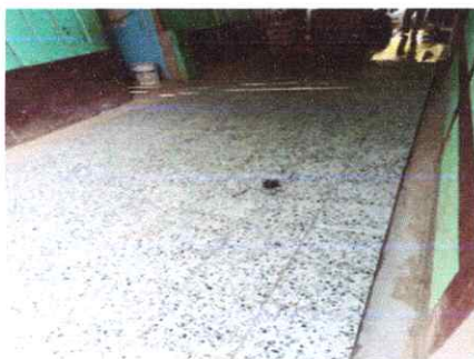
Foto 5: proceso de colocacion de granito
