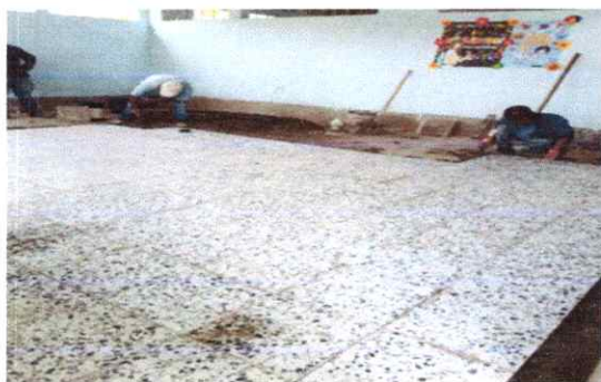
Foto 3: proceso de colocacion de granito
