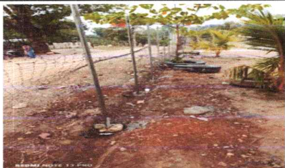
Foto 5: Proceso de colocacion de la maya,
