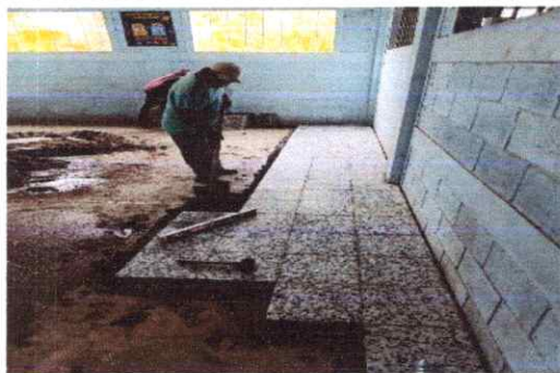
Foto1: proceso de colocacion de granito
