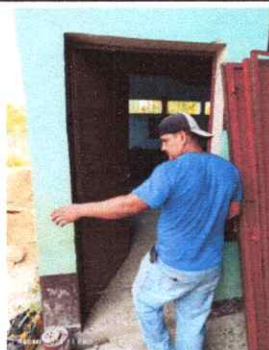
Foto 4:Proceso de colocacion de puertas
