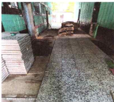
Foto 3: Proceso de colocacion de piso
