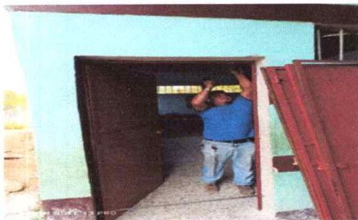
Foto1: Proceso de colocacion de puertas
