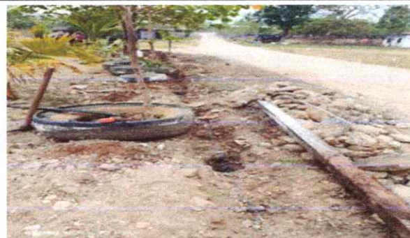
Foto 6: Proceso de colocacion de la maya,
