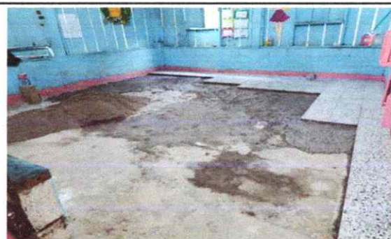
Foto 6: proceso de colocacion de granito
