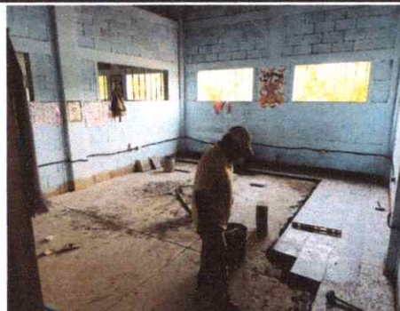
Foto 2: Proceso de colocacion piso
