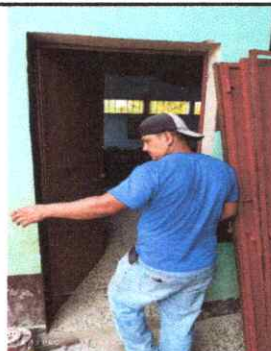
Foto 4: Proceso de colocacion de puerta
