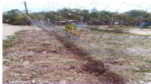
Foto 2: Proceso de colocacion de la maya,
