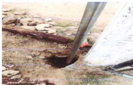
Foto 4: Proceso de colocacion de la maya,
