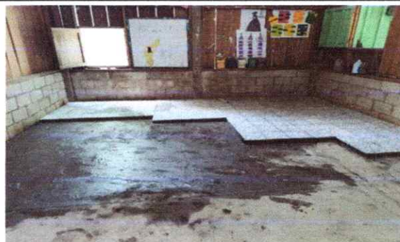
Foto 4: proceso de colocacion de granito
