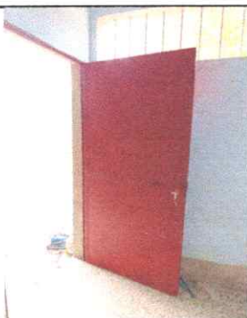
Foto 5:Proceso de colocacion de puertas
