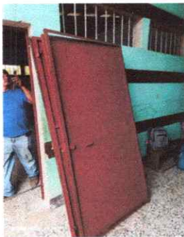
Foto 3:Proceso de colocacion de puertas
