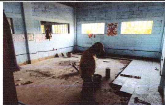
Foto 2: proceso de colocacion de granito
