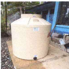
Foto 5: Sustitucion de deposito de agua 1700 LT.
