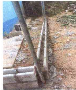
Foto 4: Reparacion de muro perimetral, con block, tubo hg y malla galvanizada
