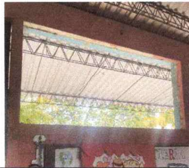
Foto 2: Ventana Sustitucion de balcon ce metal
