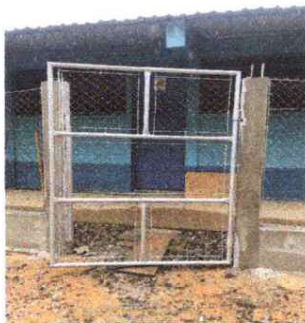
Foto 3: Mantenimiento a portones de metal
