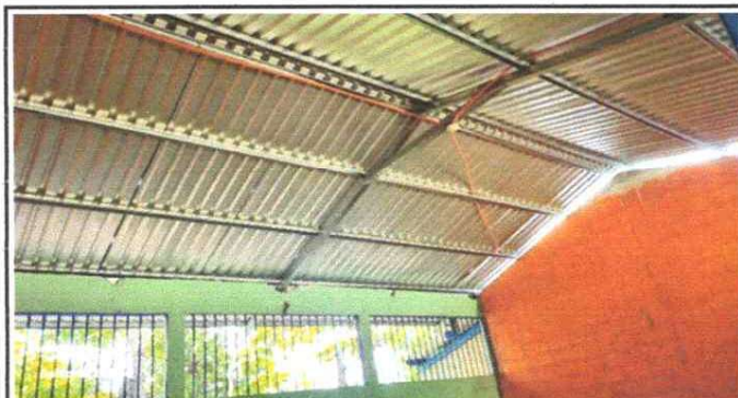
Foto 9: Cambio de lámina por deterioro
