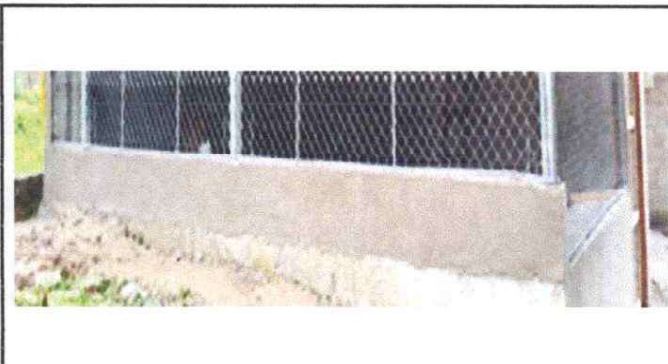
Foto 10: Reparación de muro de contención
