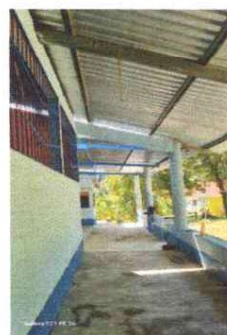
Foto 6: Cambio de soporte de mader por metal.
