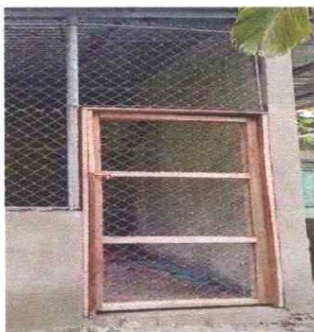
Foto 3: Sustitución de puerta de cocina
