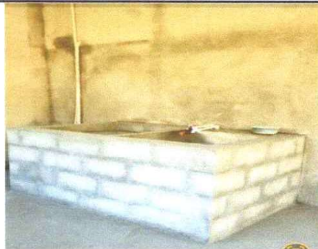
Foto 2: Construcción de Pila con 1 lavadero en la cocina del establecimiento
