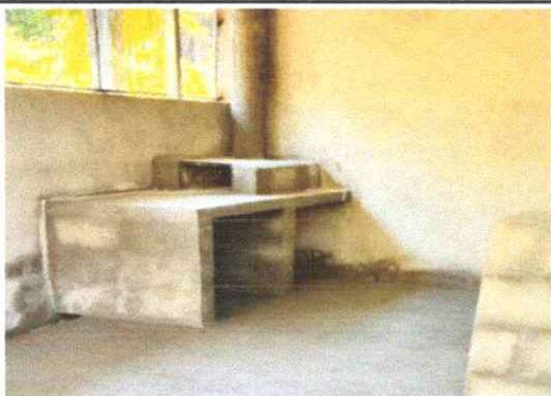
Foto 1: Construcción de hornilla de la cocina del establecimiento
