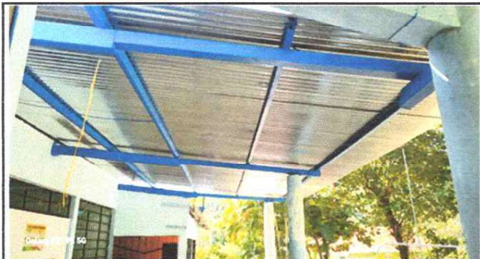
Foto 7: Mantenimiento de soporte de metal y cambio de lámina por deterioro
