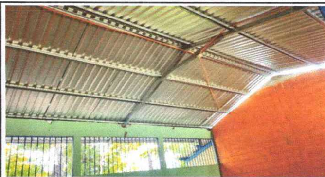
Foto 8: Cambio de estructura de madera por metal y lámina
