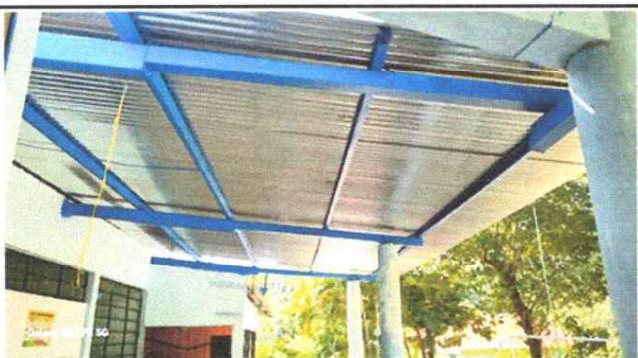
Foto 5: Mantenimiento y pintura de la estructura metálica
