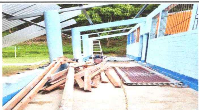
Foto 9: Cambio de lámina deteriorada por lámina troquelada Aluzinc calibre 26
