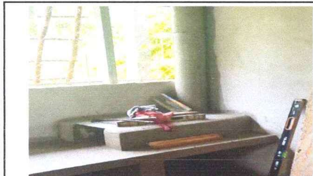
Foto 1: Hornilla de la cocina del establecimiento en proceso de construcción
