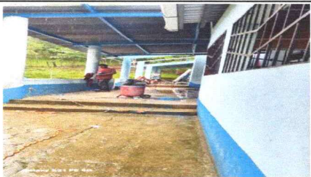
Foto 7: Mantenimiento de soporte de metal y cambio de lámina
