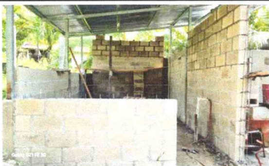
Foto 11: Condiciones de la cocina del establecimiento durante la construcción y reparación del muro de contención
