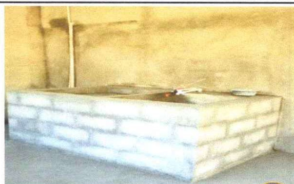
Foto 2: Elaboración de pila de 1 lavadero en cocina del establecimiento
