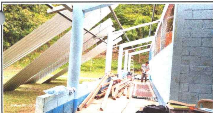
Foto 5: Cambio de estructura de techo de madera a metalica
