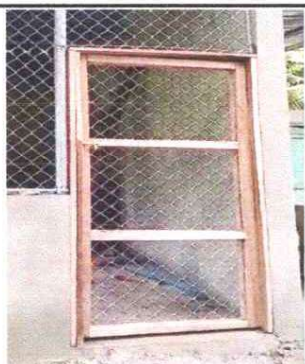
Foto 3: Sustitución de puerta de cocina
