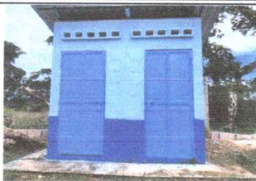
Sustitución de puertas
