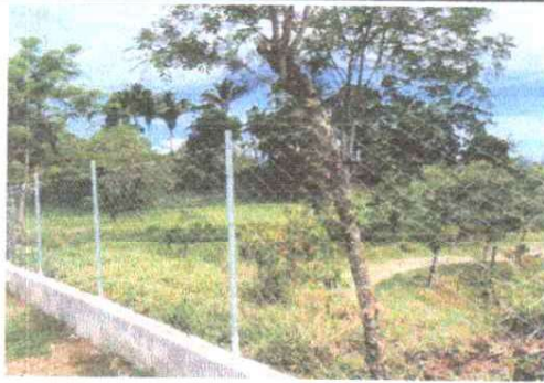
Reparación de Muro de contención
