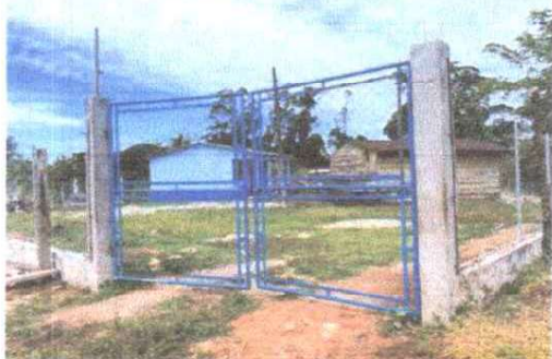
Reparación de muro perimetral de Block
