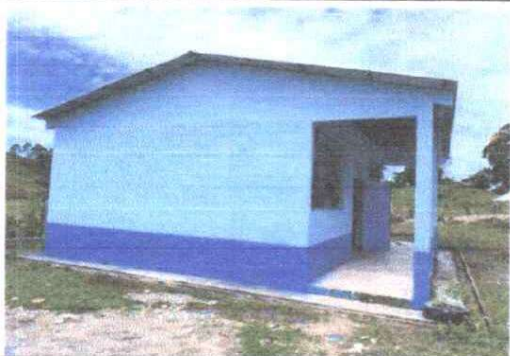
Pintura en muros exteriores e interiores
