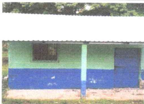
Pintura en muros exteriores e interiores
