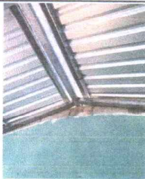
Sustitución de lámina, por lámina troquelada aluzinc calibre 26
