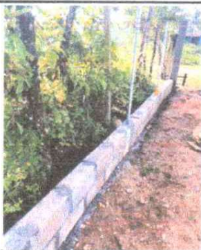
Reparación de Muro de Contención
