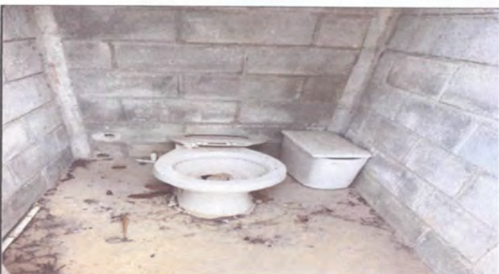
sustitución de Inodoros
