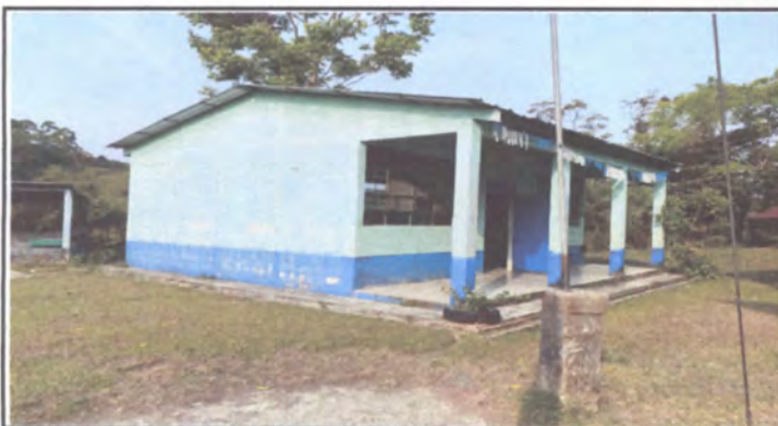
Pintura en muros exteriores e interiores
