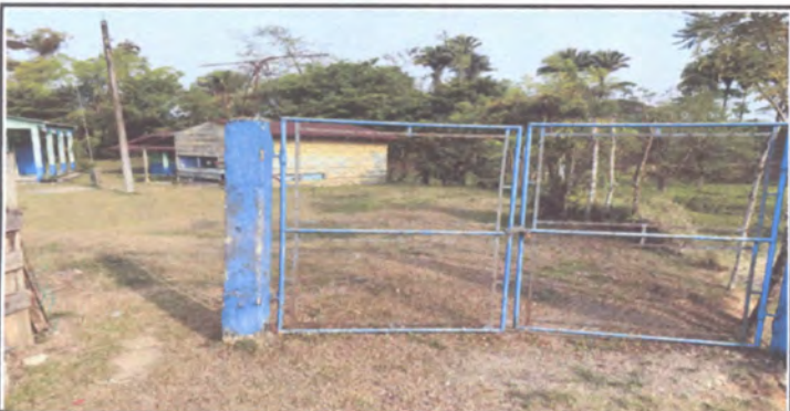
Reparacion de muro perimetral de Block
