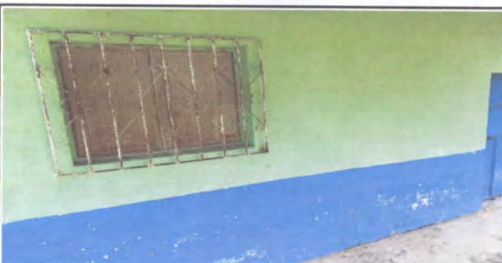
fabricación e instalación de ventana-balcon de metal
