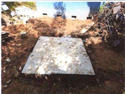
Foto 1: Mantenimiento de Fosa Séptica
