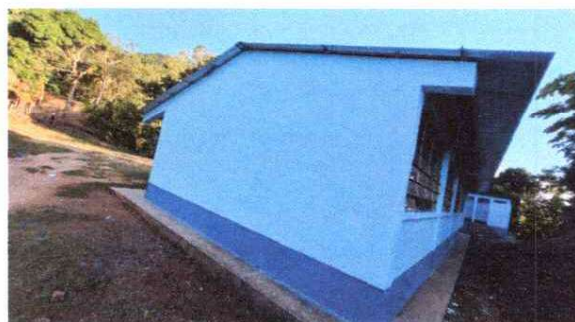
Foto 4: Mantenimiento de pintura, muros exteriores y interiores
