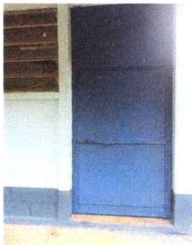
Foto1: Sustitucion de Puertas de metal para aulas
