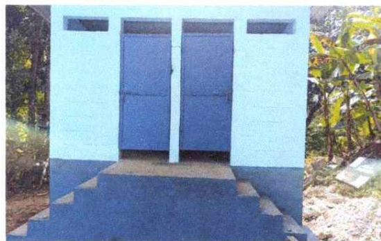
Foto 2: Sustitución de puertas de metal para baños
