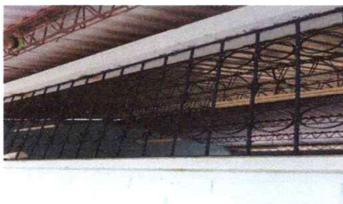
Foto 3: Sustitución de Balcones por nuevos
