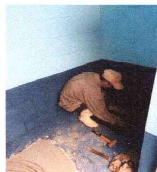
Foto 4: Mantenimiento de baños, de letrina a baños lavables
