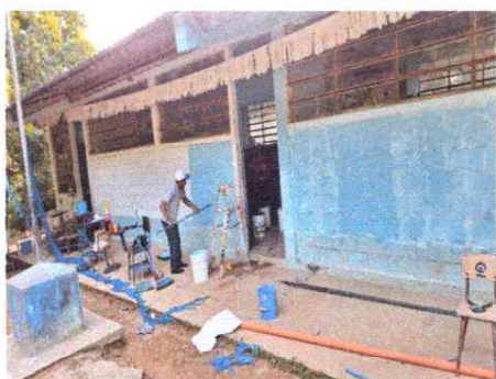
Foto 3: Mantenimiento de Pintura, muros exteriores y interiores
