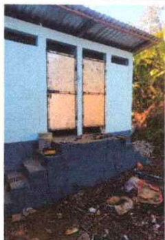
Foto1: Sustritucion de Puertas de meta para Baños
