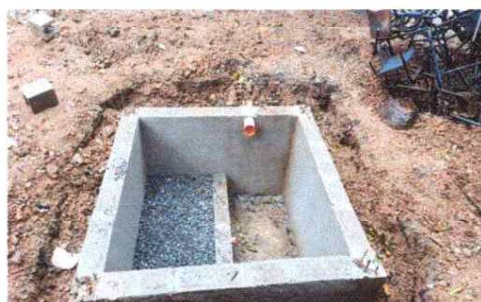
Foto 6: Mantenimineto de fosa septica
