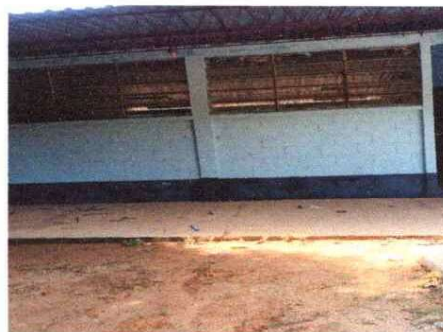
Foto 2: Sustritucion de Balcones
