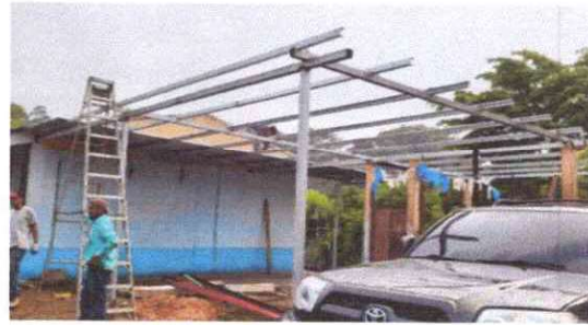
Foto 18: Sustrucción de estructura de soporte de madera, por metal
