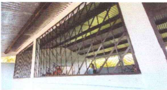
Foto 21: Mantenimiento a estructura de metal de ventana
