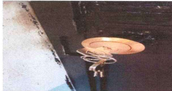
Foto 24: sustitución de chapa
