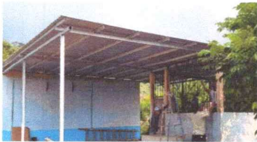
Foto 17: Sustrucción de lámina, por lámina troquelada aluzinc calibre 26
