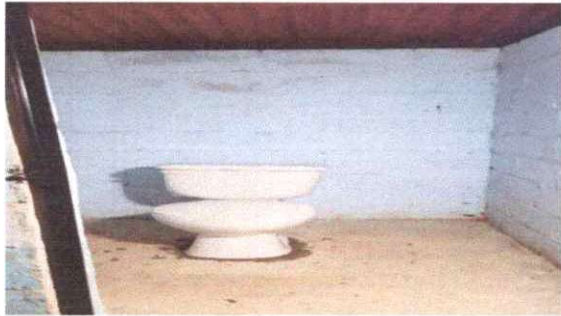
Foto 23: Sustitución de inodoro
