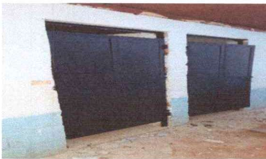
Foto 19: Mantenimiento a estructura (lijado, cambio de tubo, cepillado, sujeciones, aplicación de pintura) Y sustitución de chapa
