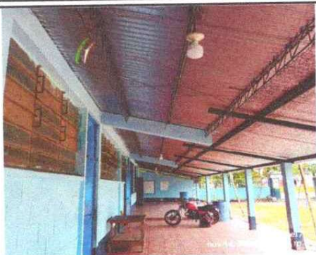
Foto7: Sustitución de plafoneras
