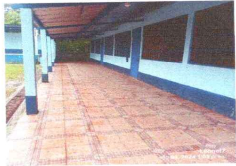
Foto 4: Sustitución de piso cerámico
