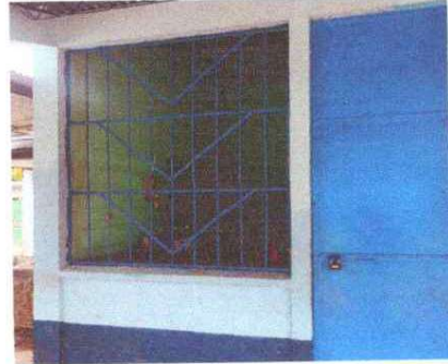
Foto 2: Sustitución de Balcones de metal
