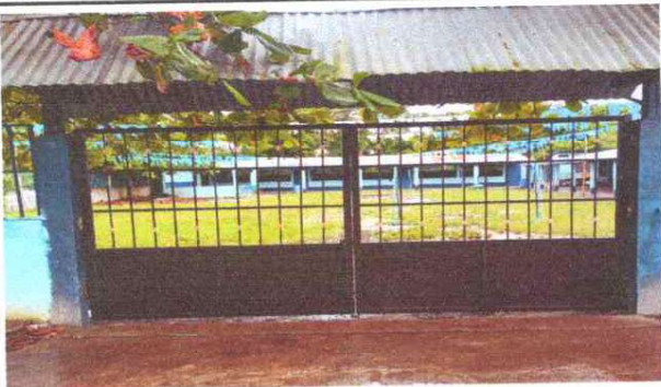
Foto 3: Sustitución de portón de metal
