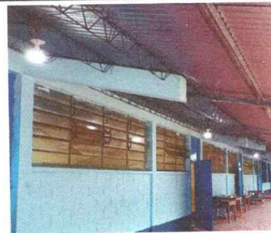
Foto 6: Sustitución de focos ahorradores
