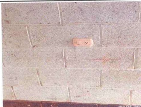
Foto 8: Sustitución de tomacorrientes dobles
