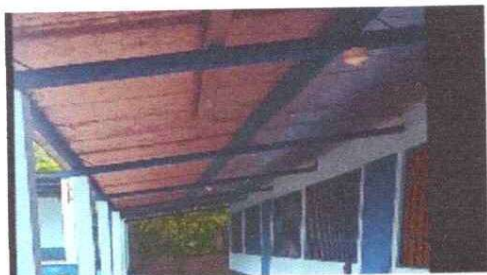
Foto 9: Mantenimiento a estructura de soporte de metal.
