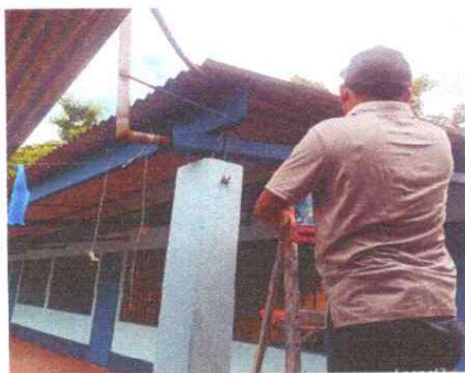
Foto 9: Mantenimiento a estructura de soporte de metal.
