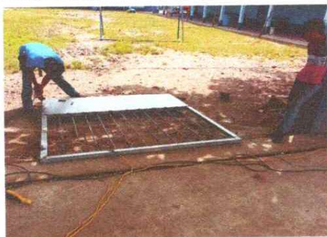
Foto 3: Sustitución de portón de metal
