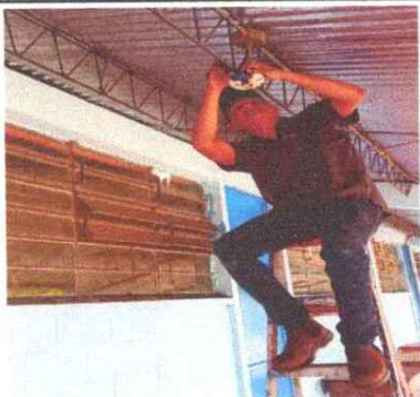
Foto7: Sustitución de plafoneras
