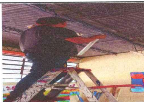
Foto 6: Sustitución de focos ahorradores
