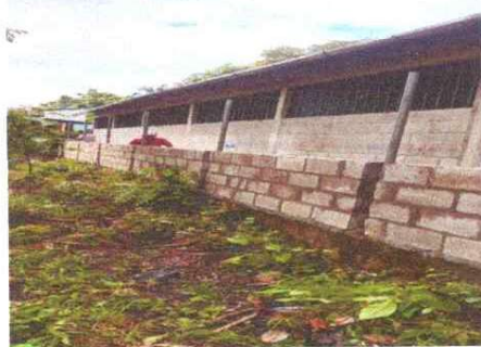
Foto 5: Seguimiento de muro perimetral
