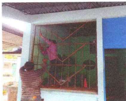
Foto 2: Sustitución de Balcones de metal
