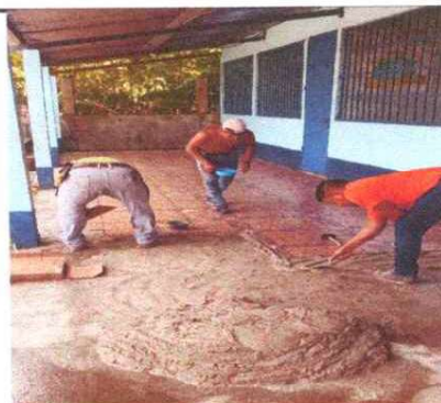
Foto 4: Sustitución de piso cerámico
