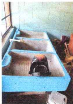
Foto 1 : Remozamiento sustitución de 2 pilas con su drenaje, agua entubada y chorros.
