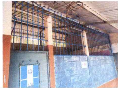
Foto 6 : Remozamiento Sustitución de balcones de metal.
