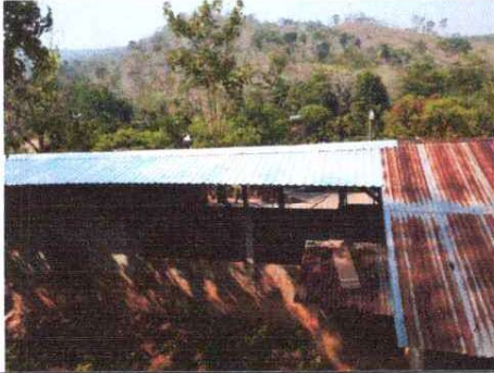
Foto 1 : Remozamiento Sustitución de lámina y estructura de madera a metal.
