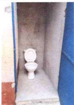
Foto 3 : Remozamiento sustitución de 3 sanitarios con sus accesorios completos, drenaje y agua
