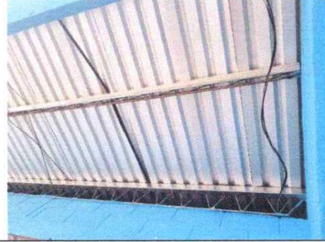
Foto 2 : Remozamiento Sustitución de estructura metálica por metálica.
