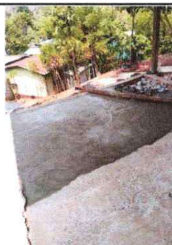
Foto 6 : Remozamiento y sustitución de piso de cemento hundido y quebrado.
