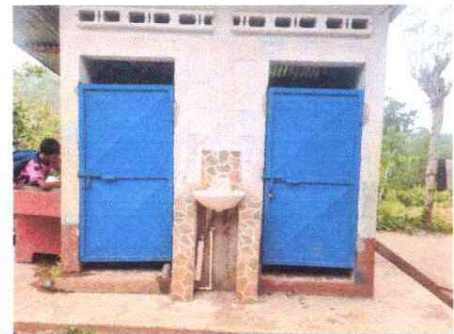
Foto 5 : Remozamiento Sustitución de 2 puertas metálicas de baño y sustitución de 2 pilas de cemento de 2 lavaderos.
