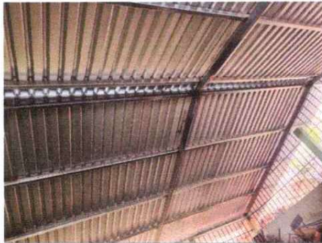
Foto 3 : Remozamiento Sustitución de estructura de madera por metálica.
