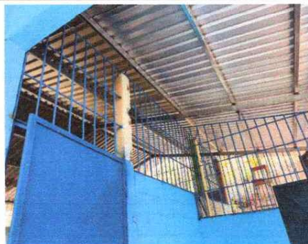
Foto 2 : Remozamiento sustitución de balcones de malla metálica por balcones de hierro.
