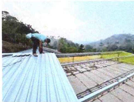
Foto 2: Remozamiento Sustitución de estructura metálica por metálica.
