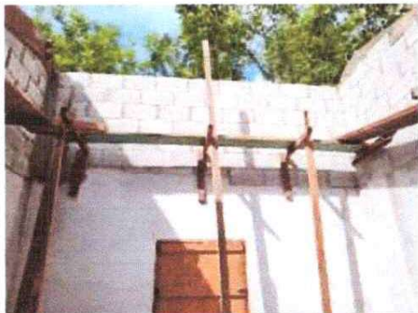
Foto 1: Remozamiento Mojinete para el techo y la lámina, Aula y Dirección.
