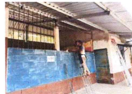
Foto 6: Remozamiento Sustitución de balcones de malla metálica por Balcones de hierro.
