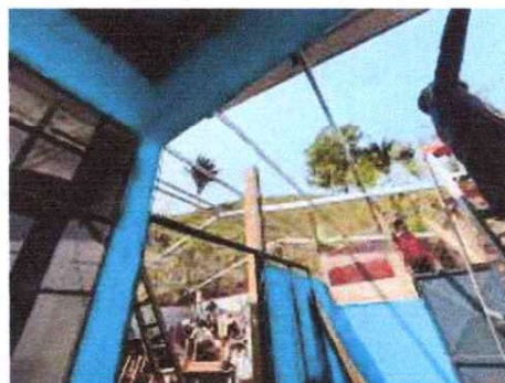
Foto 4: Remozamiento Sustitución de puerta de metal por puerta de metal.
