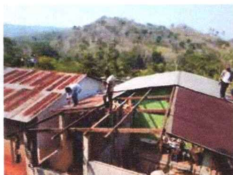
Foto 3: Remozamiento Sustitución de estructura de madera por metálica y láminas.
