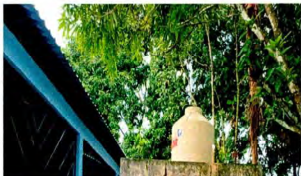
Foto 15: SUSTITUCION DE DEPOSITO DE AGUA
