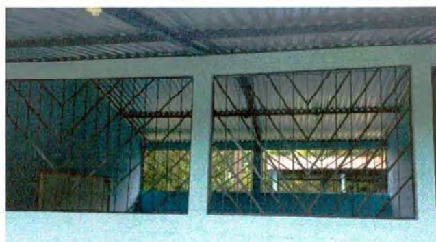
Foto 3: MANTENIMIENTO A ESTRUCTURA
