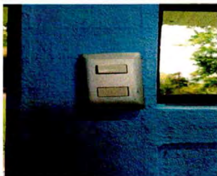
Foto 11: SUSTITUCION DE INTERRUPTORES DOBLES
