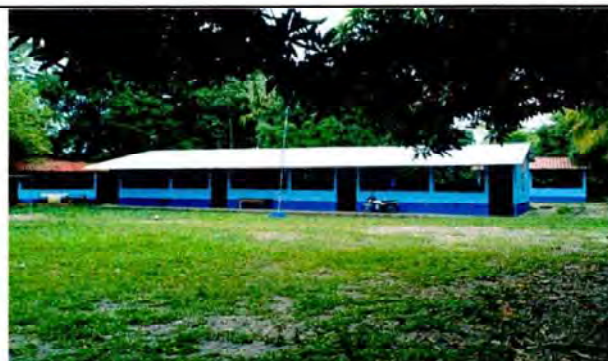
Foto 16: Pintura del establecimiento
