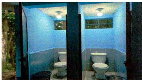
Foto 5: SUSTITUCION DE INODORO
