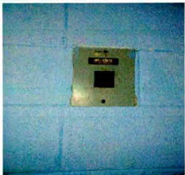
Foto 13: SUSTITUCION DE FLIPONES
