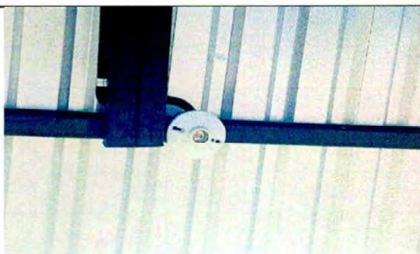
Foto 9: SUSTITUCION DE PLAFONERAS
