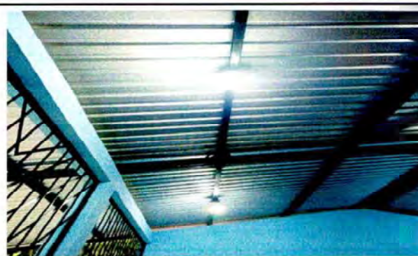
Foto 8: SUSTITUCION DE FOCOS AHORRDORES
