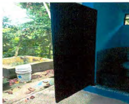
Foto 4: SUSTITUCION DE PUERTA
