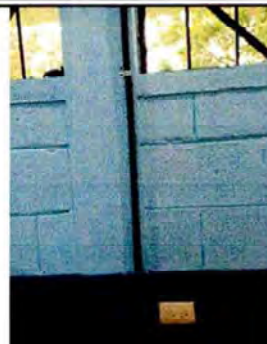
Foto 14: REPARACION DE CABLEADO ELECTRICO
