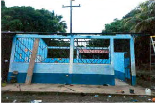
Foto 1: SUSTITUCION DE LAMINA
