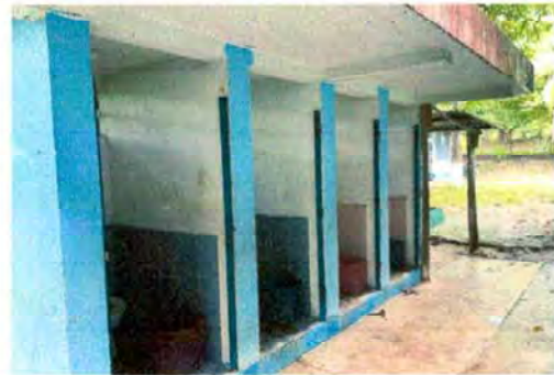
Foto 4: SUSTITUCION DE PUERTAS DE BAÑO
