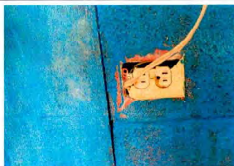
Foto 12: SUSTITUCION DE TOMACORRIENTES
