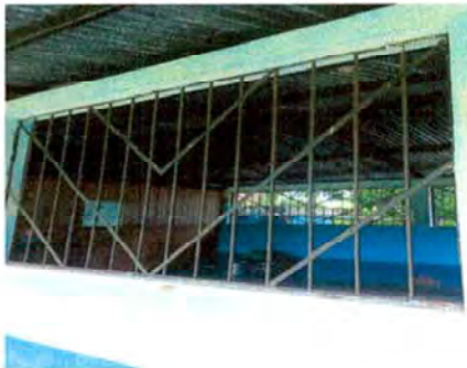
Foto 3: MANTENIMIENTO DE ESTRUCTURA METALICA
