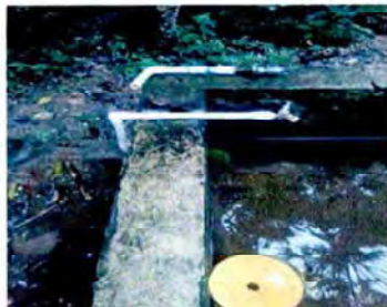
Foto 7: SUSTITUCION DE LLAVE DE CHORRO
