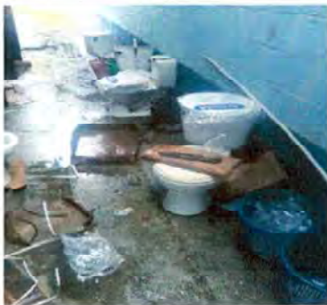
Foto 5: SUSTITUCION DE INODOROS
