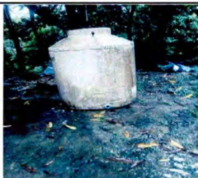
Foto 15: SUSTITUCION DE DEPOSITO DE GUA 1700 lt.
