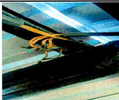
Foto 11: SUSTITUCION DE INTERRUPTORES DOBLES
