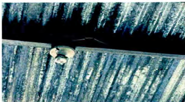
Foto 9: SUSTITUCION DE PLAFONERAS
