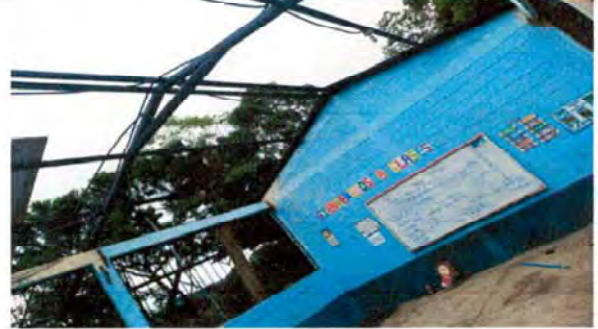
Foto 2: SUSTITUCION DE CAPOTE DE LAMINA
