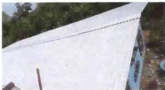
Foto 3: SUSTITUCION DE ESTRUCTURA DE TECHO
