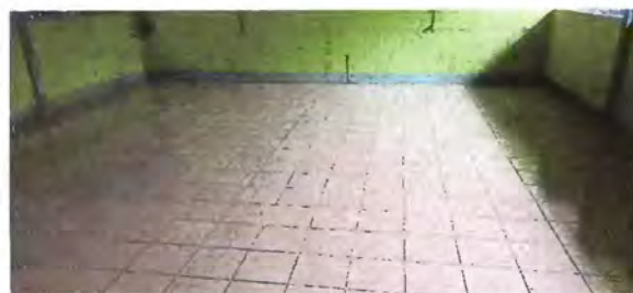
Foto 2: SUSTITUCION DE PISO POR PISO CERAMICO
