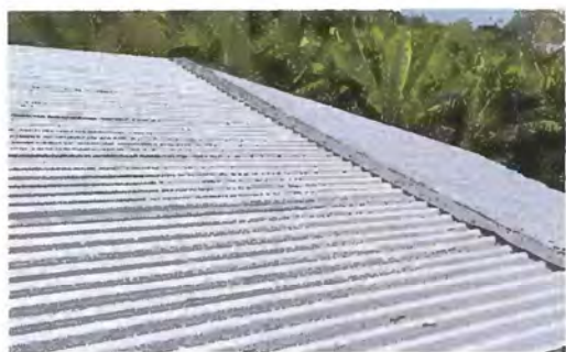
Foto 1: MANTENIMIENTO A TECHO
