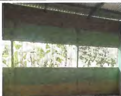
Foto 5: LEVANTAMIENTO DE ESTRUCTURA
