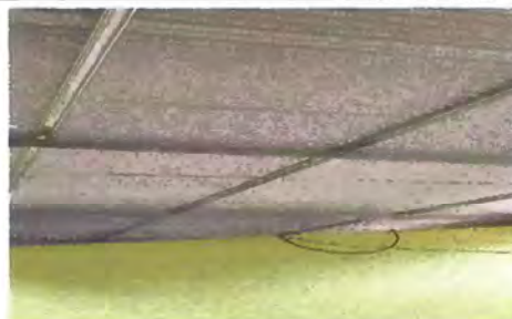
Foto 4: SUSTITUCION DE TECHO
