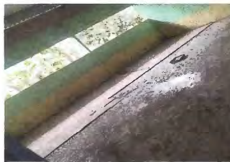
Foto 2: SUSTITUCION DE PISO POR PISO CERAMICO
