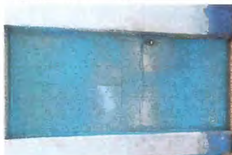
Foto 6: MANTENIMIENTO A PUERTAS DE METAL
