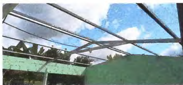
Foto 4: SUSTITUCION DE TECHO
