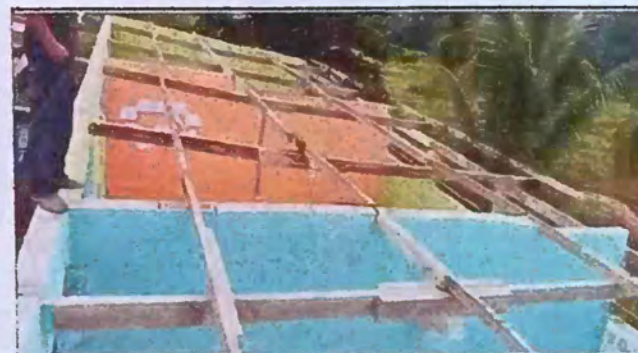
Foto 4: CAMBIO DE MADERA POR COSTANERA.
