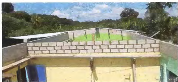
Foto 5: LEVANTAMIENTO DE ESTRUCTURA
