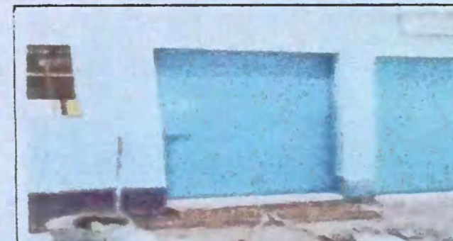
Foto 6: MANTENIMIENTO DE PUESTAS DE METAL.
