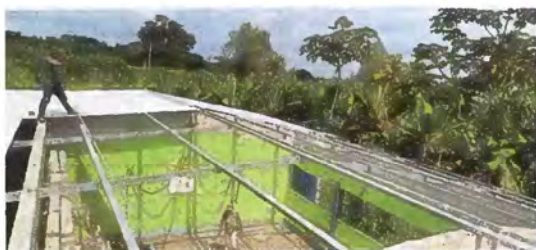
Foto 3: SUSTITUCION DE ESTRUCTURA DE TECHO
