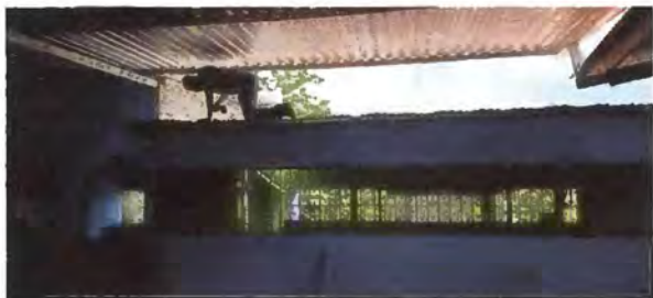
Foto 1: MANTENIMIENTO A TECHO
