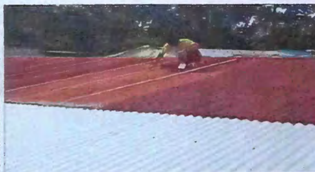
Foto 3: MANTENIMIENTO DE TECHO.
