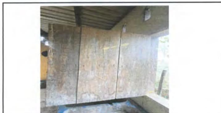
SUSTICUCION DE VENTANA
