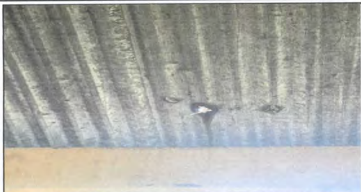
SUSTITUCION DE LAMINA POR LAMINA TROQUELADA CALIBRE 36
