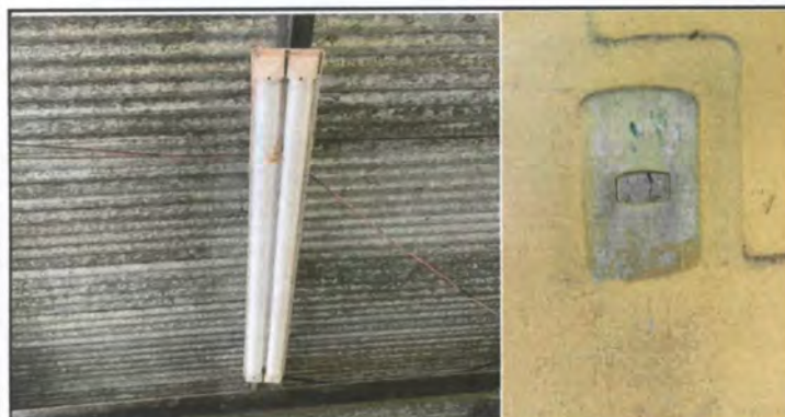
SUSTITUCION DE LAMPARAS E INTERRUPTORES
