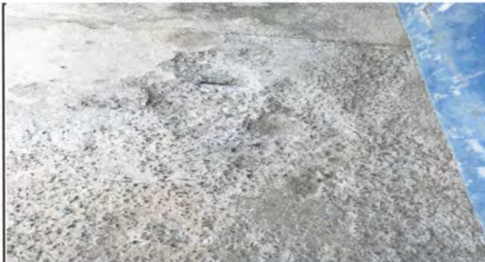
REPARACION DE PISO CONCRETO
