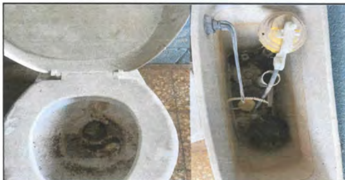
SUSTITUCION DE ACCESORIOS DE INODOROS
