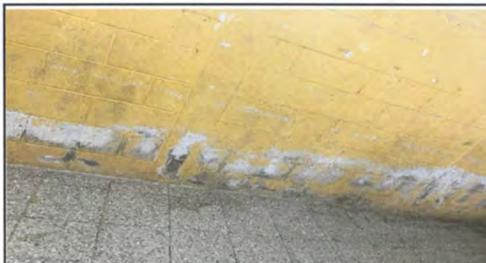
SISTITUCION NDE PINTURA INTERIOR Y EXTERIOR
