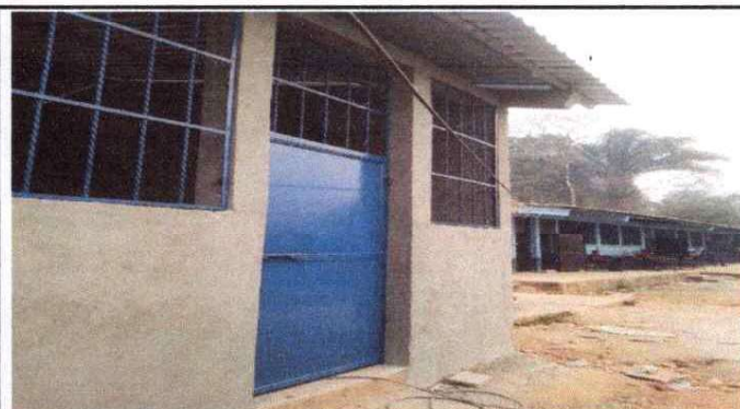
foto 2: Instalación de Puertas Metálicas.
