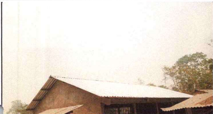
Foto 1: Instalación de Láminas
