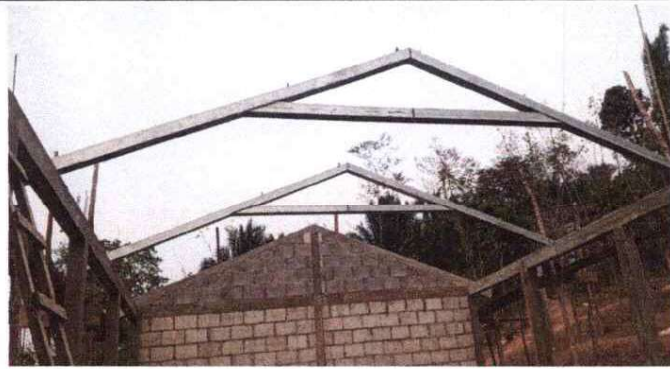
2. FABRICACIÓN E INSTALACIÓN DE ESTRUCTURA METALICA.
