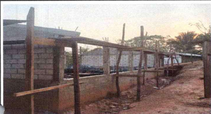
1. LEVANTAMIENTO DE MURO.
