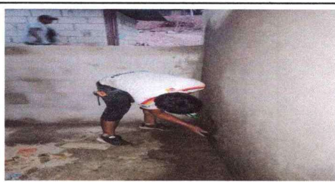
6. REPELLO DE MURO DEL AULA.
