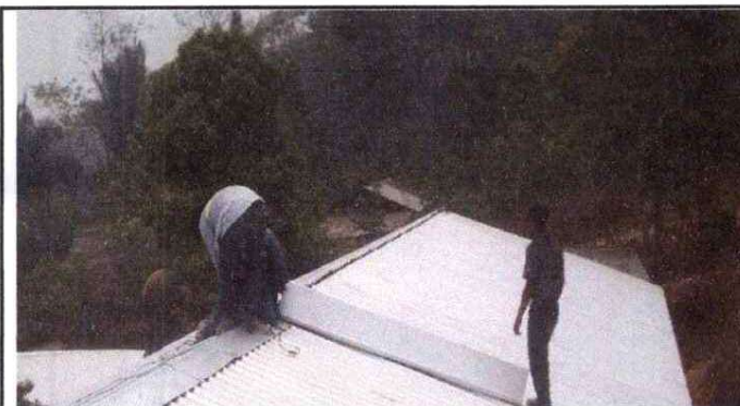
3. INSTALACIÓN DE LAMINAS TROQUELADAS.
