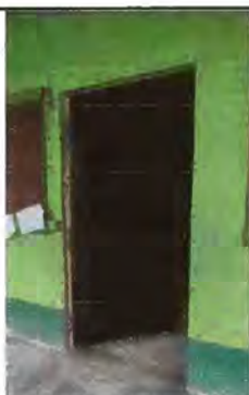
Foto 9: Sustrucción de puerta de madera en mal estado por puerta de metal
