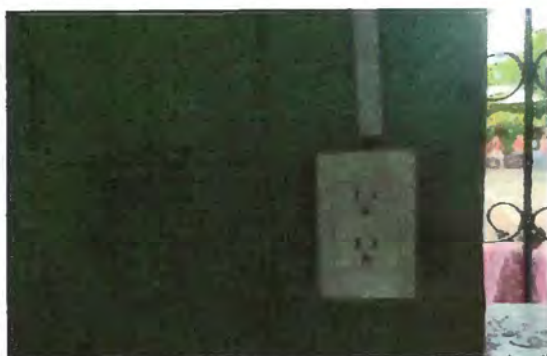
Foto 15: Reparación de sistema eléctrico
