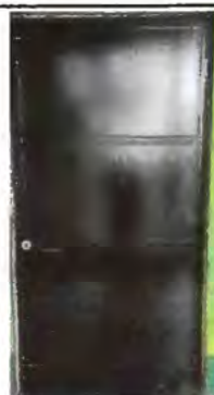
Foto 10: Sustrucción de puerta de madera en mal estado por puerta de metal
