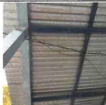
Foto 4: Sustitución de lámina con agujeros por lámina troquelada aluzinc calibre 26
