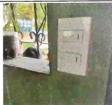
Foto 14: Reparación de sistema eléctrico
