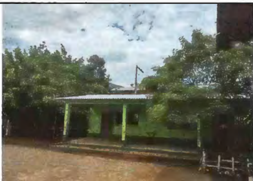
Foto 1: Sustitución de lámina en mal estado por lámina troquelada aluzinc calibre 26
