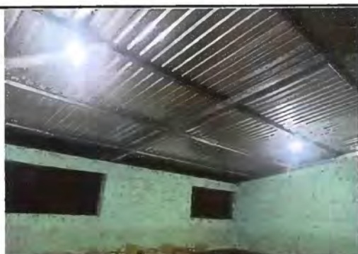
Foto 17: Reparación de sistema eléctrico
