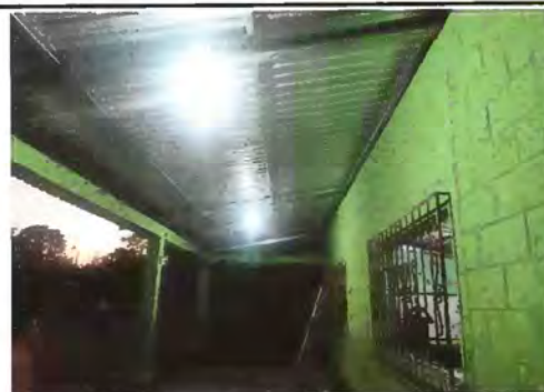
Foto 18: Reparación de sistema eléctrico
