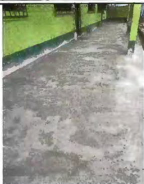
Foto 13: Sustrucción de piso de torta de concreto
