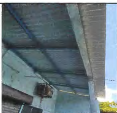
Foto 5: Sustitución de lámina con agujeros por lámina troquelada aluzinc calibre 26
