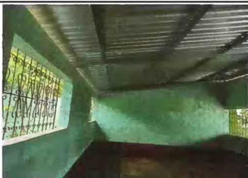
Foto 3: Sustitución de lámina en mal estado por lámina troquelada aluzinc calibre 26
