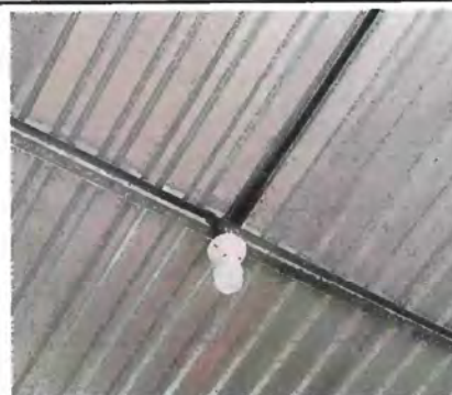
Foto 16: Reparación de sistema eléctrico
