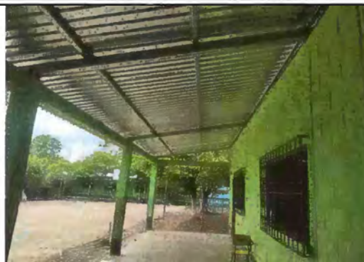
Foto 2: Sustitución de lámina en mal estado por lámina troquelada aluzinc calibre 26
