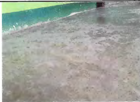
Foto 12: Sustrucción de piso de torta de concreto
