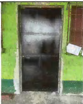
Foto 7: Sustrucción de puerta de madera en mal estado por puerta de metal
