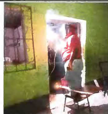
Foto 16: Sustitución de puerta de madera en mal estado por puerta de metal
