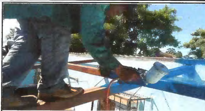
Foto 8: Mantenimiento a estructura de soporte de metal
