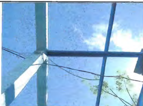
Foto 9: Mantenimiento a estructura de soporte de metal
