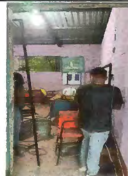
Foto 14: Sustitución de puerta de madera en mal estado por puerta de metal
