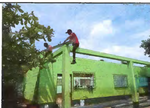
Foto 10: Sustitución de estructura de soporte de madera, por metal
