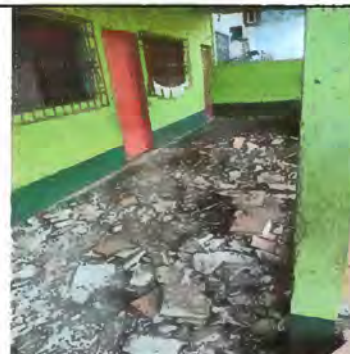
Foto 18: Sustitución de piso de torta de concreto
