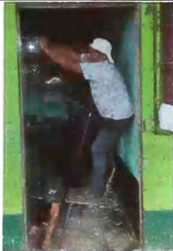
Foto 13: Sustitución de puerta de madera en mal estado por puerta de metal
