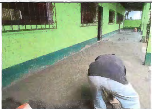
Foto 19: Sustitución de piso de torta de concreto
