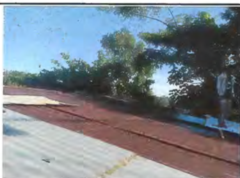
Foto 5: Sustitución de lámina con agujeros por lámina troquelada aluzinc calibre 26
