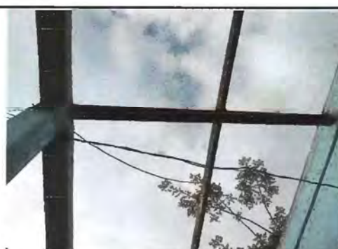
Foto 6: Sustitución de lámina con agujeros por lámina troquelada aluzinc calibre 26
