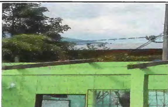
Foto 3: Sustitución de lámina en mal estado por lámina troquelada aluzinc calibre 26
