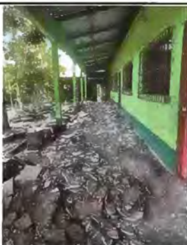
Foto 17: Sustitución de piso de torta de concreto
