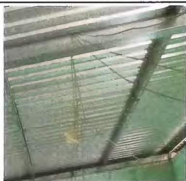
Foto 21: Reparación de sistema eléctrico
