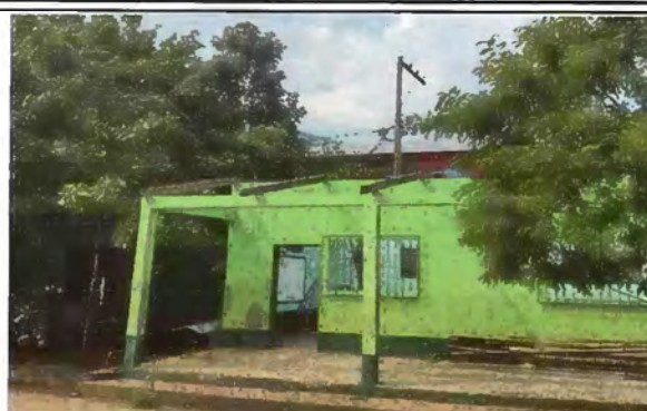
Foto 2: Sustitución de lámina en mal estado por lámina troquelada aluzinc calibre 26
