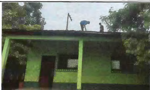
Foto 1: Sustitución de lámina en mal estado por lámina troquelada aluzinc calibre 26
