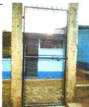
FOTO 5: Sustrucción de portón de metal
