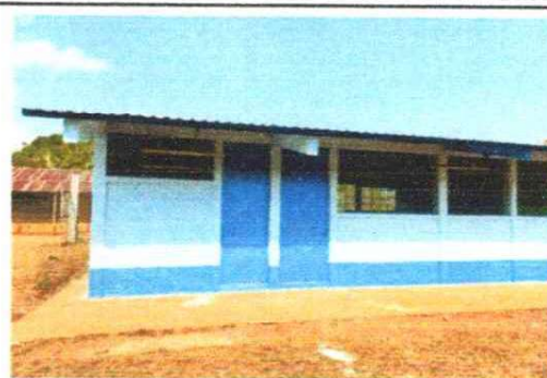
FOTO 2: Sustrucción de lámina por lámina troquelada
