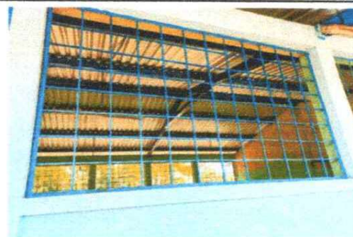
FOTO 6: Sustrucción de balcones de metal
