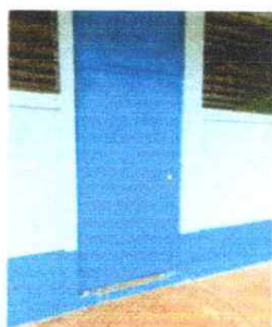
FOTO 3: Sustrucción de puertas
