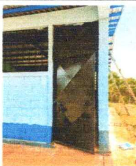
FOTO 10: Reparación de puertas y sustitución de chapa
