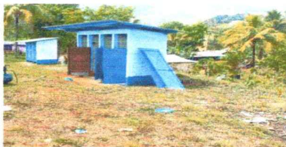
FOTO 4: SUSTITUCION DE PUERTAS DE BAÑOS
