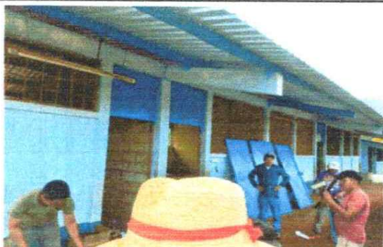
FOTO 3: SUSTITUCION DE PUERTAS DE AULA
