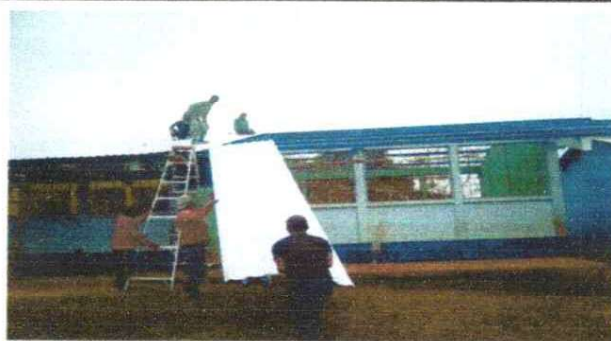
FOTO 2: Instalación de láminas troqueladas
