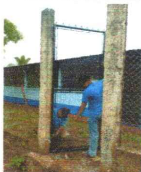
FOTO 5: SUSTITUCION DE PORTON DE METAL
