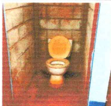
FOTO 9: Sustitución de inodoro
