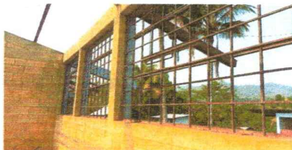
FOTO 6: SUSTITUCION DE BALCONES
