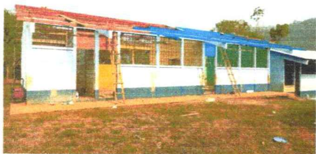
FOTO 1: SUSTITUCION DE LAMINA
