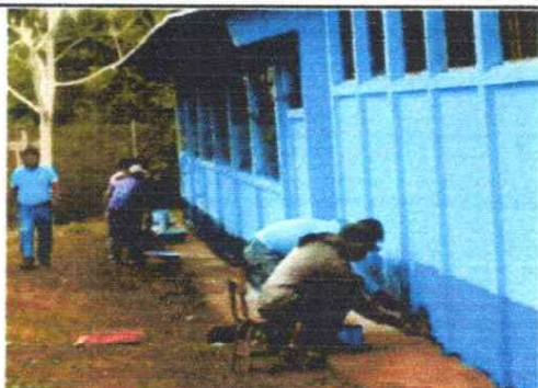
FOTO 7: PINTURAS EN MUROS INTERIOR Y EXTERIOR
