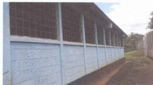
FOTO 6: SUSTITUCION DE BALCONES
