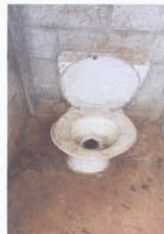
FOTO 8: SUSTITUCION DE INODORO
