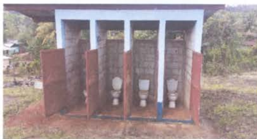
FOTO 2: SUSTITUCION DE LAMINA DE BAÑOS
