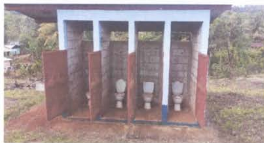
FOTO 4: SUSTITUCION DE PUERTA DE BAÑOS
