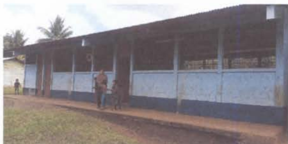
FOTO 7: PINTURA EN MUROS INTERIORES Y EXTERIORES
