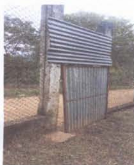
FOTO 5: SUSTITUCION DE PORTON DE METAL
