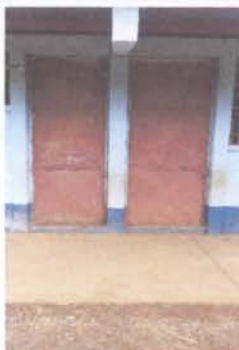
FOTO 3: SUSTITUCION DE PUERTAS DE AULA
