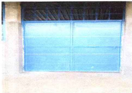
Sustitución de puerta de madera por metal
