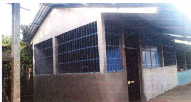
Levantamiento de muro de cocina de block.
