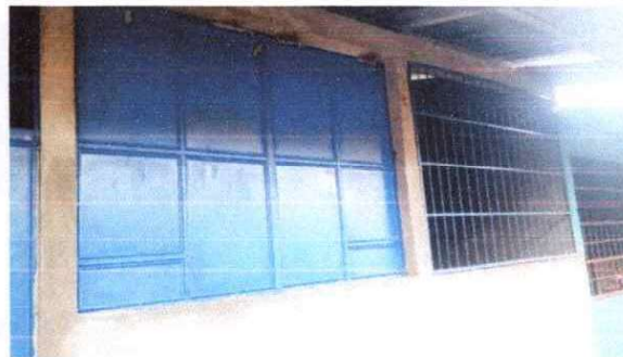
Sustitución de balcones de madera de madera por metal.
