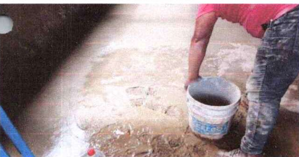
Sustitución de piso de torta de concreto
