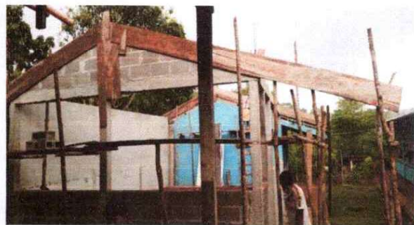
Levantamiento de muro de cocina de block.
