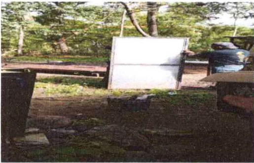
Sustitución de puerta de madera por metal
