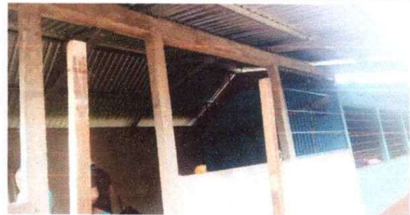
Sustitución de balcones de madera de madera por metal.
