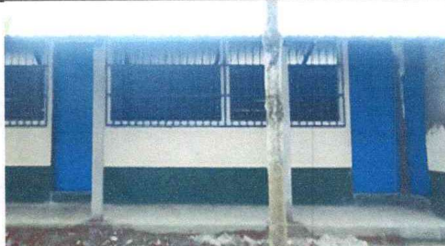
SUSTITUCIÓN DE (3) PUERTAS DE MADERA POR DE METAL DE AULAS Y BODEGA.
