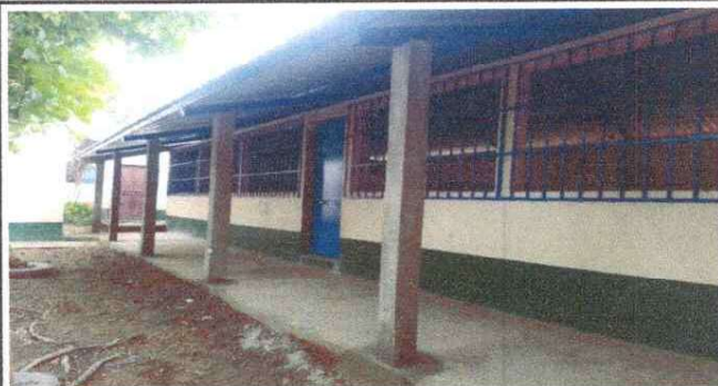
SUSTITUCIÓN BASE DE MADERA DE CORREDOR POR COLUMNAS DE CONCRETO.
