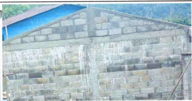
SUSTITUCIÓN MURO DE CONTENCIÓN DE MADERA POR BLOCK EN AULAS
