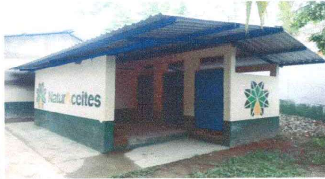
SUSTITUCIÓN DE (6) PUERTAS DE MADERA POR DE METAL EN SANITARIOS.
