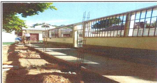
SUSTITUCIÓN BASE DE MADERA DE CORREDOR POR COLUMNAS DE CONCRETO.
