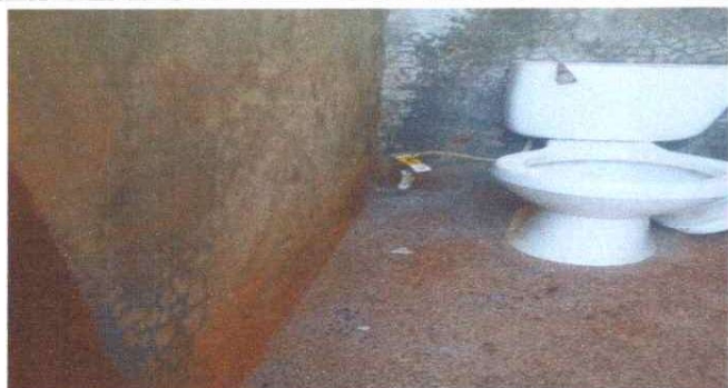
1.MANTENIMINETO DE TAZAS SANITARIOS.
