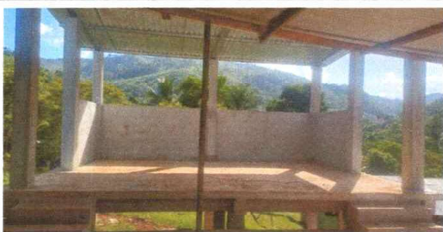
3. REPARACIÓN DE PLANCHA DE CONCRETO.
