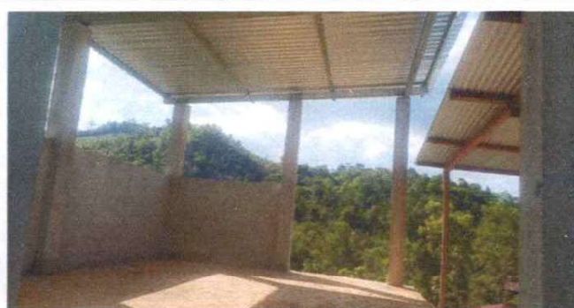
4.REPARACIÓN DE PLANCHA DE CONCRETO.
